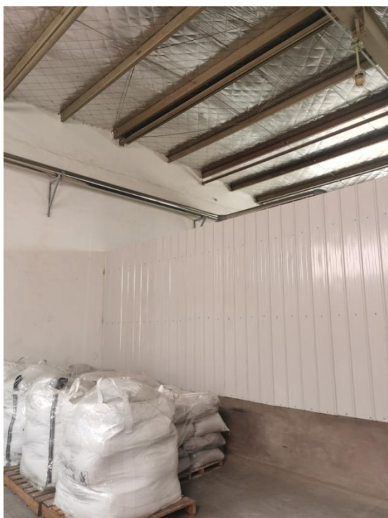
危险固废堆场废气收集管线及消防设施
