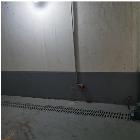
危险固废堆场易燃及有毒检测报警装置
