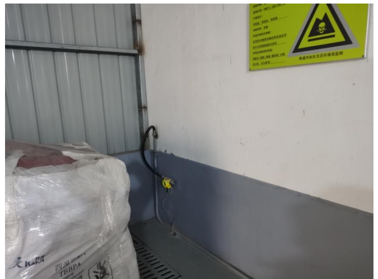
危险固废堆场易燃及有毒检测报警装置
